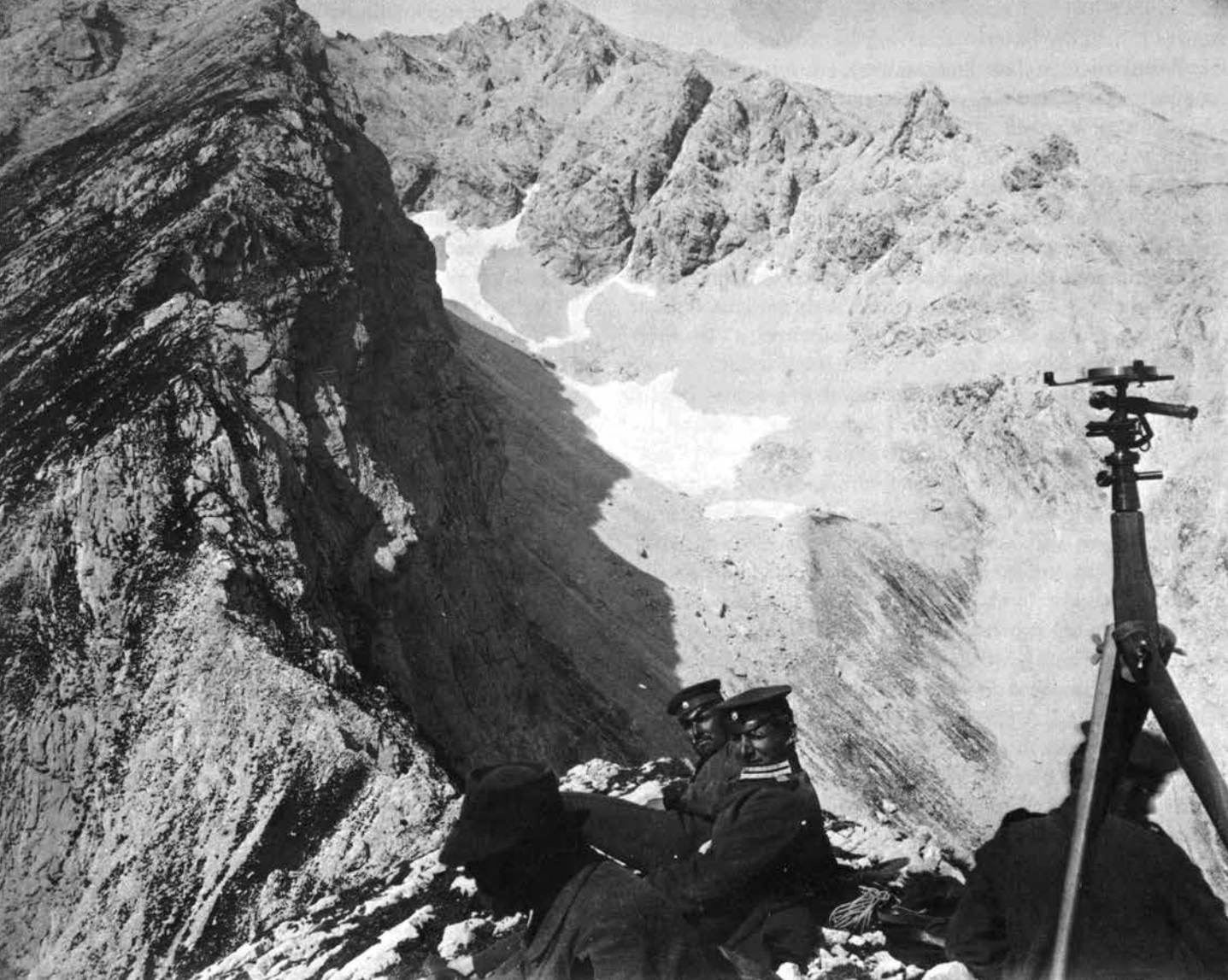
Abb. 063: Gletschervermessung mit einem Phototheodoliten auf dem Brunntalkopf, 1892
