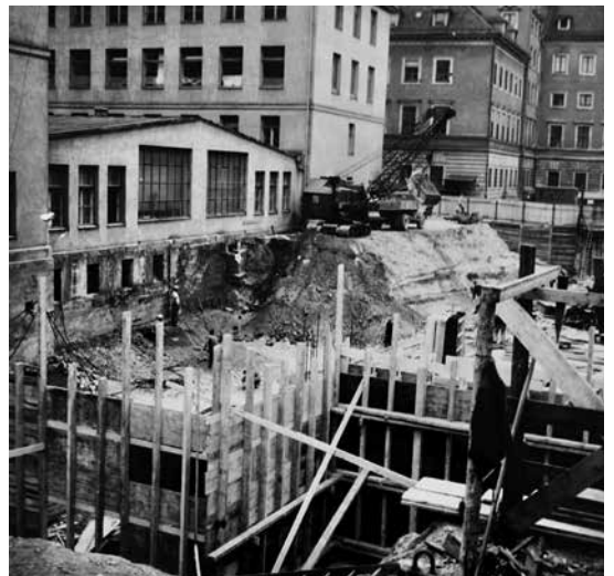
Abb. 165: Baumaßnahmen Dienstgebäude Oettingenstraße
