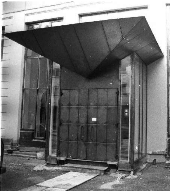
Abb. 172: Neu gestalteter Haupteingang 1990
